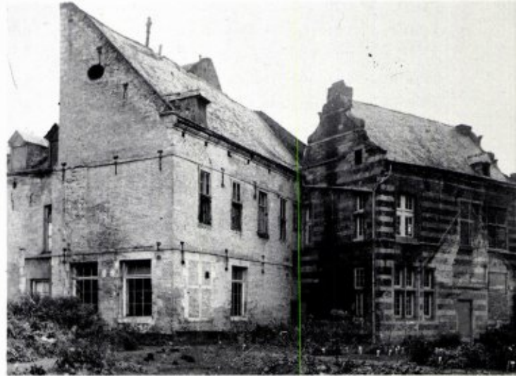
Afb. 3 – Gezicht op, rechts, het huis Stas en, links, het pand met het lessenaarsdak. Deze opname dateert van kort na 1912. Het gebouw is blijkbaar al als Natuurhistorisch Museum in gebruik, maar de aanleg van de tuin is nog in een prille fase. De op afb. 2 zichtbare aanbouw tegen de zijkant van het huis Stas is verdwenen, maar de ingrijpende restauratie moet nog komen.
